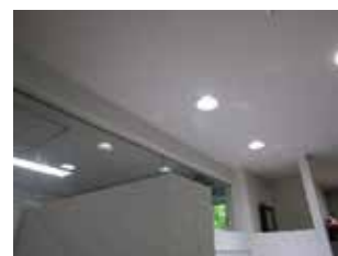
4.5階Dルーム洗面所LED 照明設置
