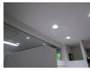
4、5階Dルーム洗面所LED 照明設置
