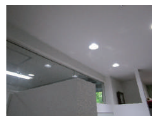
4、5階Dルーム洗面所LED 照明設置
